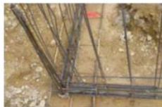
Nœud de chaînage - Continuité mécanique
